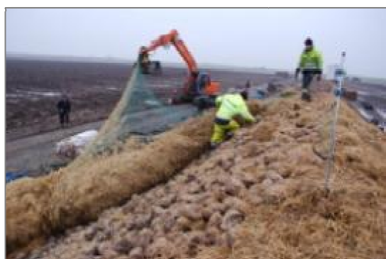
Borttagningen av halmen underlättas om den läggs på nät som kan dras av med frontlastare eller som här, grävare.
