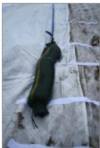
Korbborrband och sandsäckar med lina från långsida till långsida underlättar täckningsarbetet.
